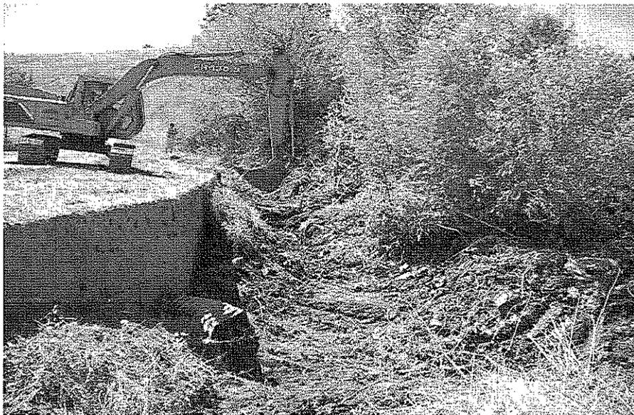
A Castelfranco si è risolto il problema dell'accumulo di materiale, a monte dell'attraversamento stradale sul vallone Macchione, della Strada comunale denominata dell'Abbeveratoio, con ostruzione della sezione del tombino avente già sezione inadeguata
