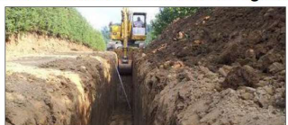
Installazione delle condotte
